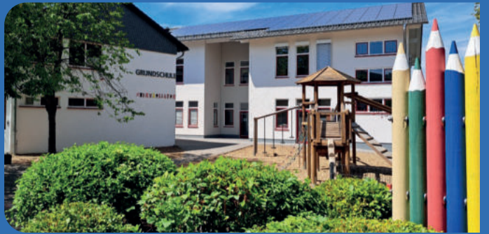
Grundschule Diefen mit Anbau
