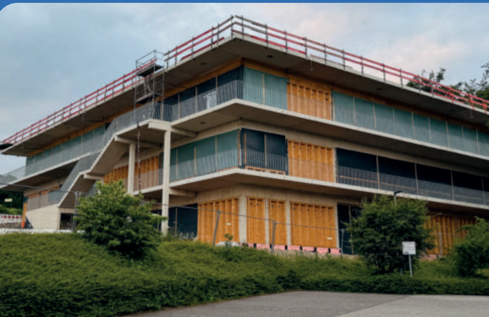
Baustelle Grundschule Wilnsdorf
