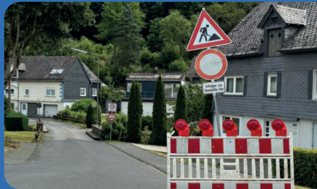
Sanierungsmaßnahmen im Verkehrsraum
